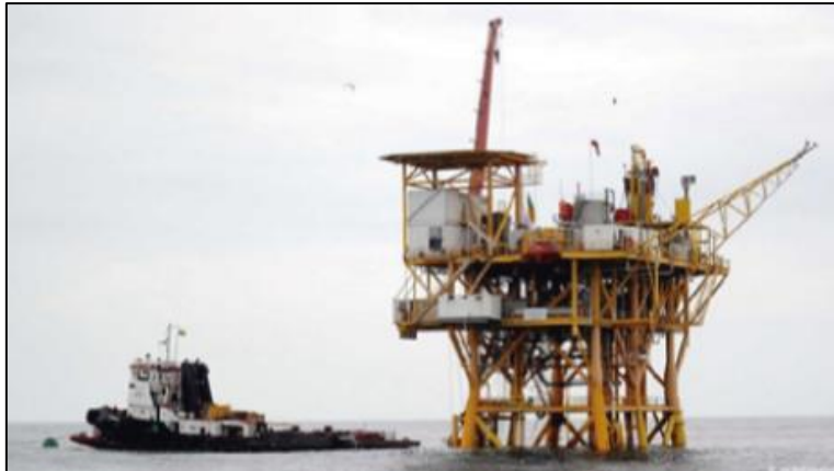
Ilustración 1: Plataforma de gas
