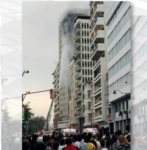
Figura 31 : Incendio Edificio Mgd.
