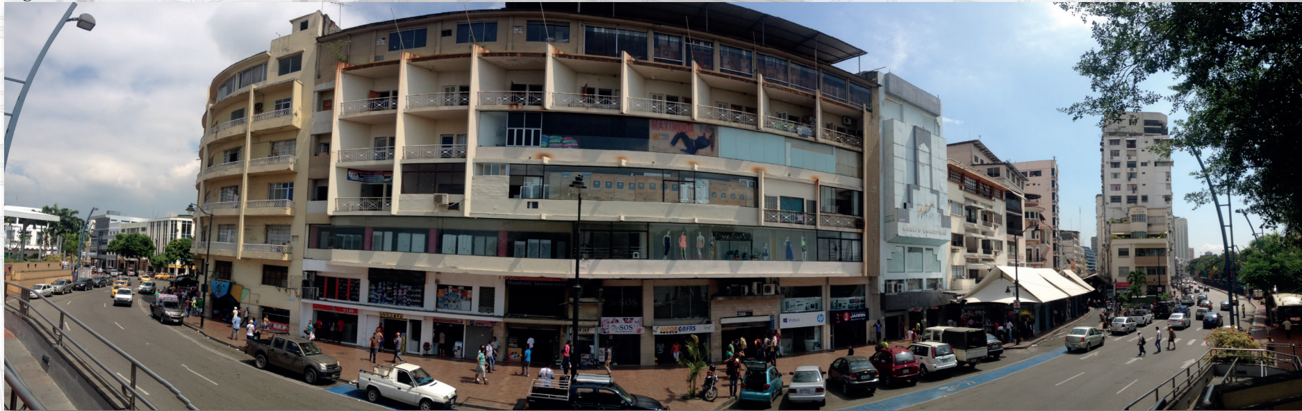
Figura 30 : Panorámica del C.C. Humboldt
