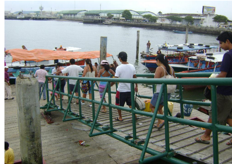
Imagen 33: Muelle de cabotaje. Fuente: (La Hora, 2010).
