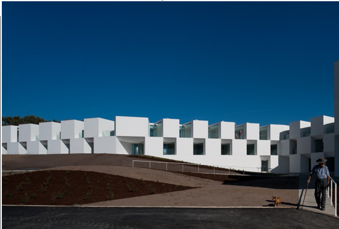
Imagen N 44 - Fachada Alcácer do Sal Residences Fuente: (Plataforma Arquitectura, 2016)
