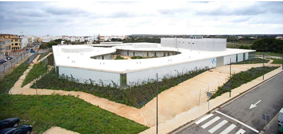
Imagen N 34 - Vista aérea del centro geriátrico Santa Rita Fuente: (Plataforma Arquitectura, 2016)
