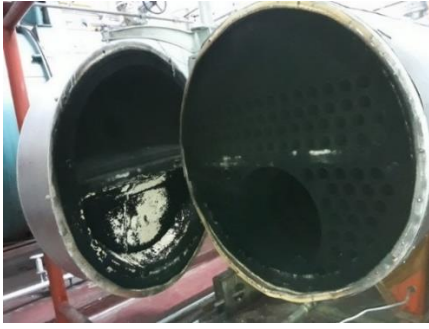
Figura 13. Refractario de la puerta (izquierda) y refractario del hogar (derecha).
