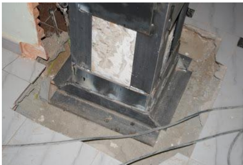
Parte inferior de una columna reforzada (Abella, 2012)
