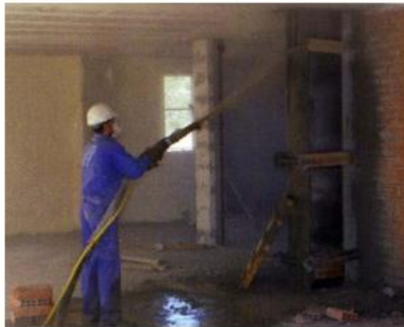
Aplicación de hormigón proyectado a columna (foto). Se observa el gunitado 1 del hormigón.
