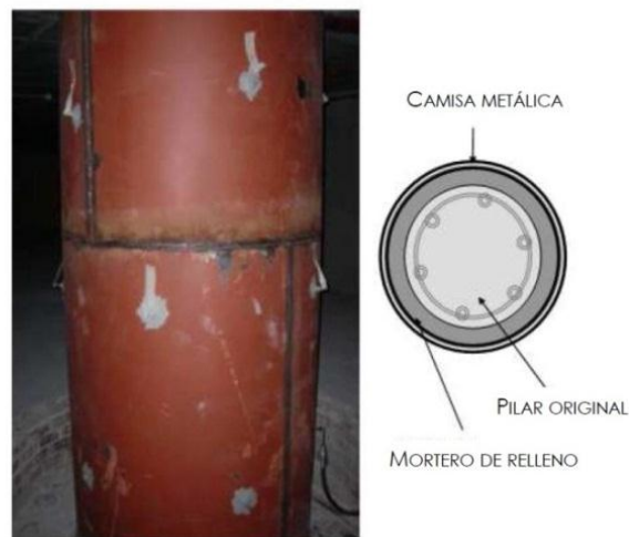
Refuerzo de soporte con encamisado continuo (STRUCTURALIA, 2017)
