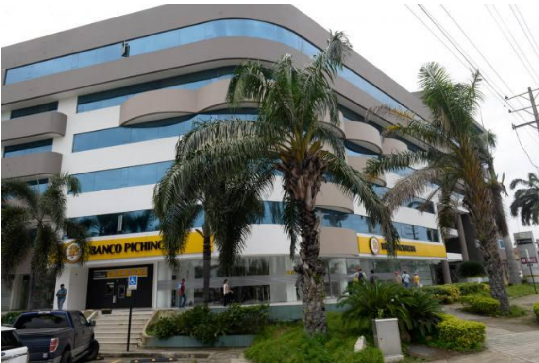
(El Universo, 2017) Edificio Samborondón Plaza luego de los trabajos ejecutados.
