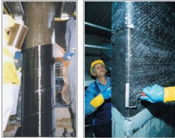
Aplicación de un confinamiento con tejidos de fibra de carbono para la rehabilitación de distintas columnas de edificación.
