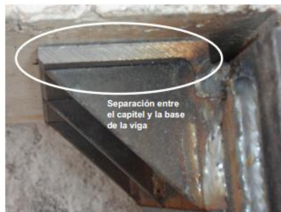
Separación entre capitel y base de viga por enfriamiento del acero (Adam, 2007)
