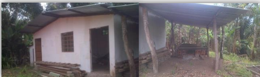
Fotografía # 12: Instalaciones de la hacienda. Fuente: autor.
