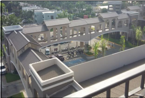
Figura # 12: Luz natural en el puente hacia el Edificio de Postgrado.
