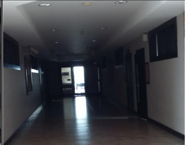
Figura # 11: Luces apagadas en el pasillo del 3er Piso – Edificio E.
