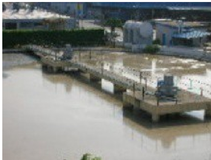
Figura 25: Planta Residual Fuente: Cervecería Nacional
