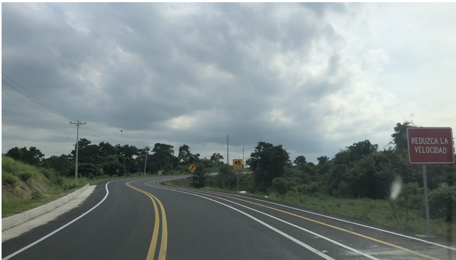
Imagen 17: Vía de acceso a Terreno B
