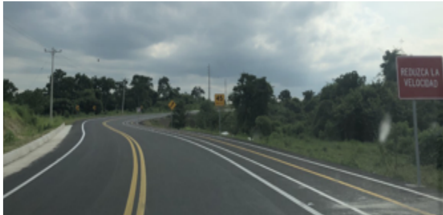
Imagen 12: Vía de acceso a Terreno B
