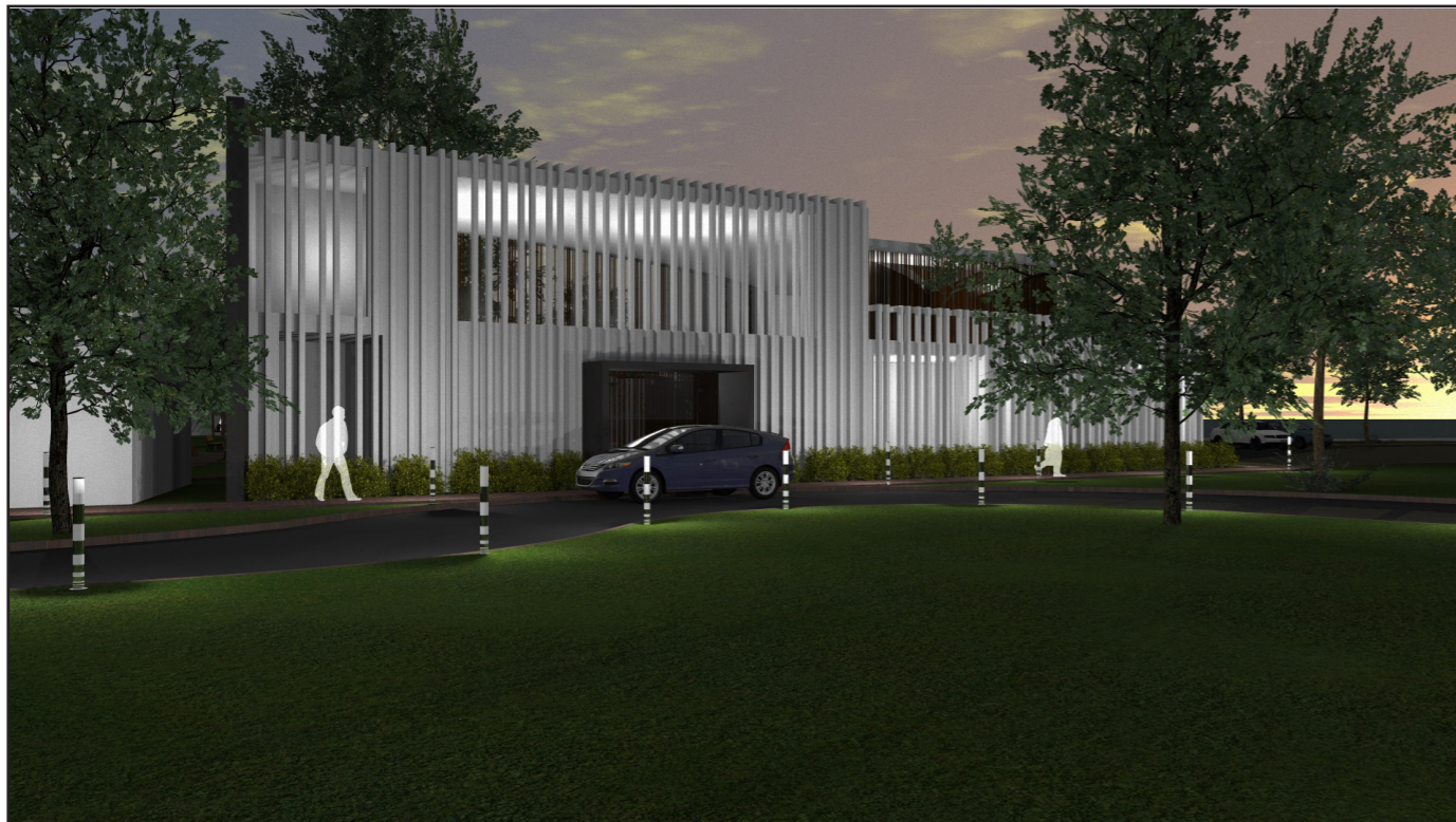
Imagen 76: Ingreso frontal edificio administrativo nocturno
