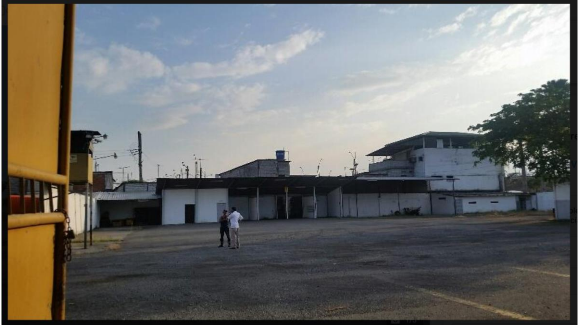
Ilustración 5 Galpón de la Planta
