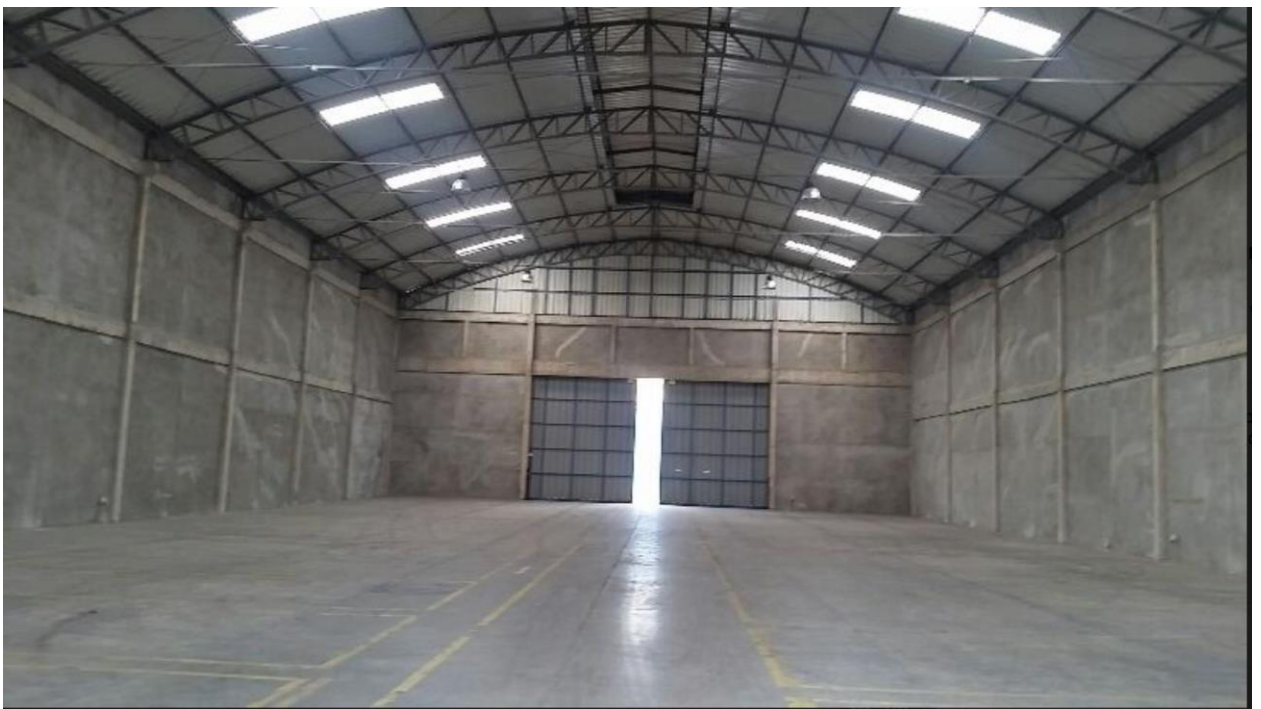
Ilustración 6 Galpón de la Planta
