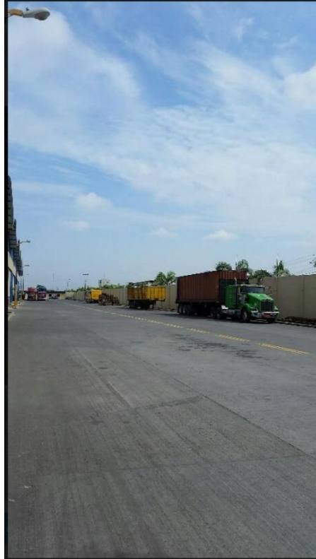
Ilustración 7 Galpón de la Planta
