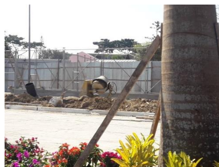
Al final de la obra se procede a retirar la maquinaria dando por terminado el contrato.
