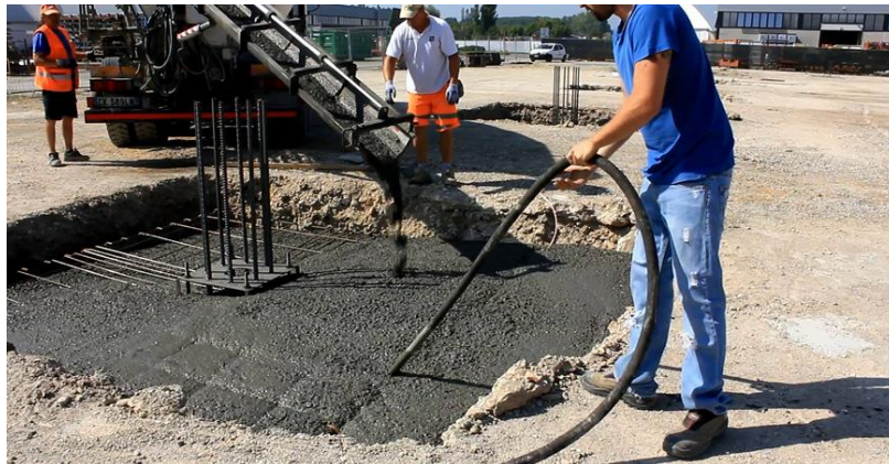
Figura 7. Trabajo de vibrador de concreto
