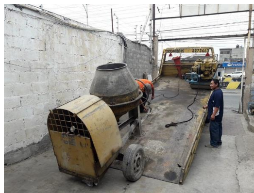
Se procede a subir la maquinaria al camión para ser transportada.
