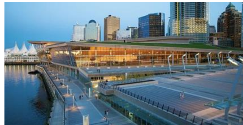
Imagen 22: Centro de Convenciones de Vancouver con certificación LEED
