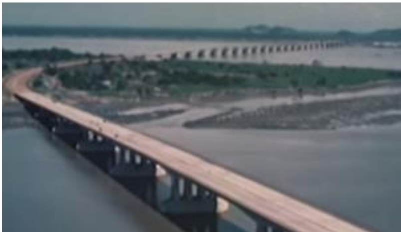
Imagen 4: Etapa final de la construcción del Puente de la Unidad Nacional
