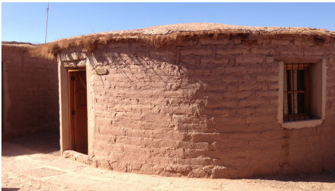
Figura 29: Construcción en tierra
