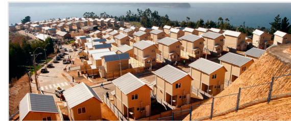
Figura 26: Viviendas sociales construidas en mader
