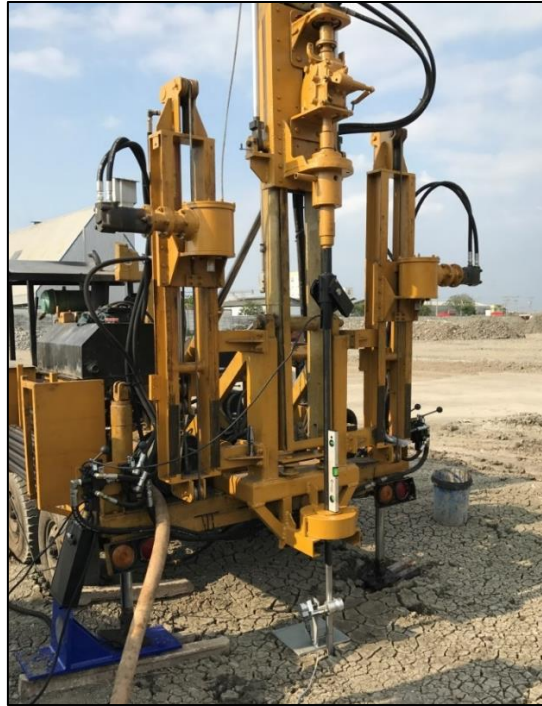
Figura 22. Ejecución en campo de un ensayo CPTu por empresa Geoestudios S.A.
