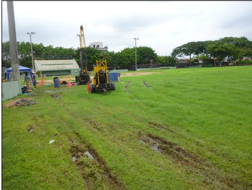
Figura 23. Fotografía de la ejecución en campo de la perforación realizada en el Estadio de Beisbol de Kennedy durante el Proyecto de Microzonificación de Guayaquil en 2014 (Vera et al 2014).
