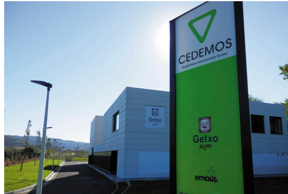
Figura 66. Vista lateral del Centro de Movilidad Sostenible CEDEMOS. Fuente: (Foraster Arquitectos, 2015)
