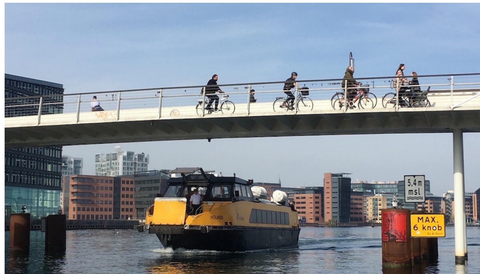
Figura 42. Infraestructura para recorridos peatonales y ciclovías en Copenhague. Fuente: (Copenhagenize, 2019)
