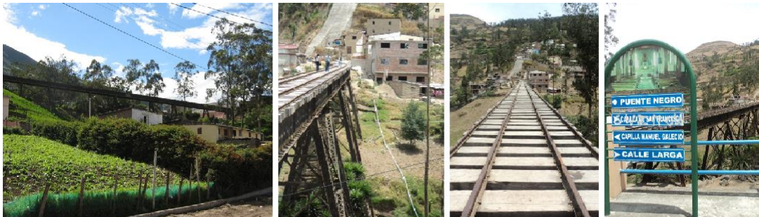
Figura 5: Compilación fotografías del Puente Negro.
