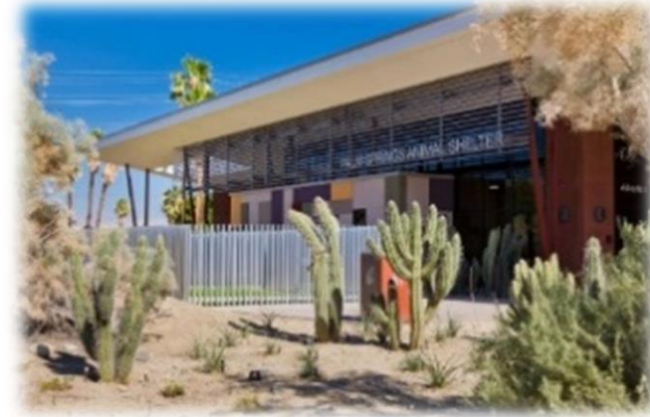
Imagen N°4. 8. Área Exterior Frontal del Palm Springs Animal Care Facility Fuente: Arch Daily (2012)
