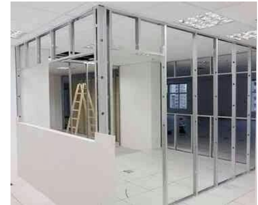
Imagen N°9. 6. Perfilería para Paredes de Gypsum Fuente: Pinterest (2020)
