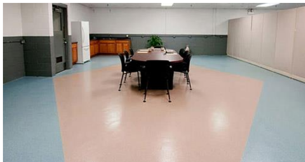
Imagen N°9. 28. Piso Epóxico Tipo FloroQuartz Fuente: Florock.net (2020)
