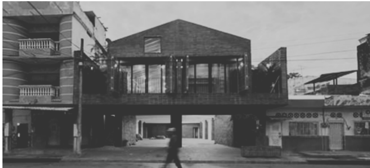
Figura 8. Vista frontal de La Casa que habita Fuente: (Plataforma Arquitectura, 2021)
