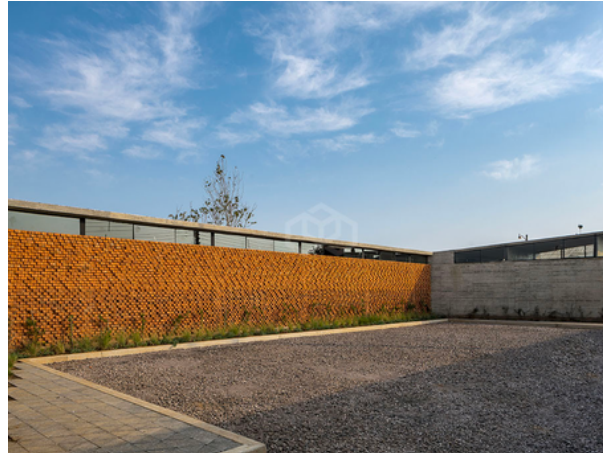
Figura 10. Fachada lateral con pared de ladrillo vista en el refugio para Mujeres Víctimas de Violencia de Género en Uruapan, México (ArchDaily, 2017)
