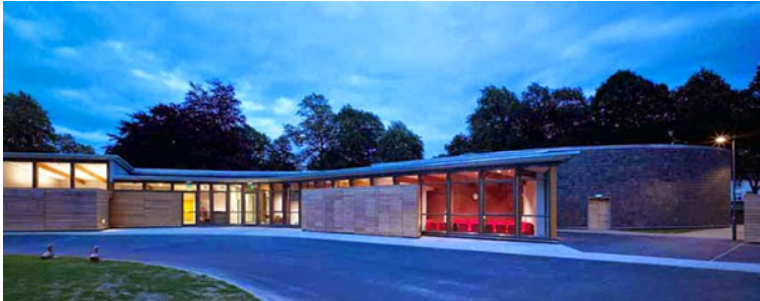
Imagen 45. Fachada de Escuela Hazelwood Fuente: (Architecture Books, 2008)
