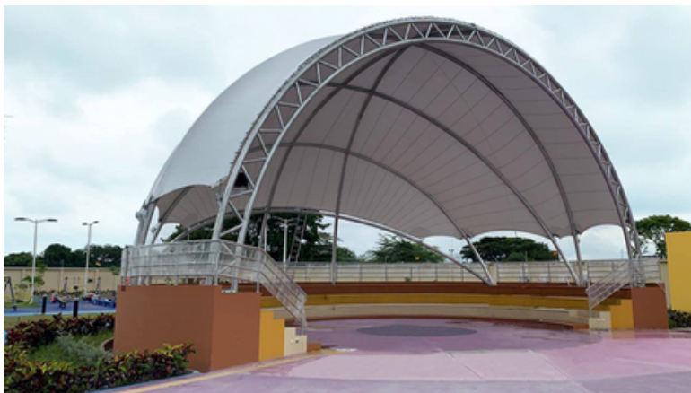
Imagen 66. Cubierta de la rotonda Fuente: (Tenzo Ecuador, 2019)
