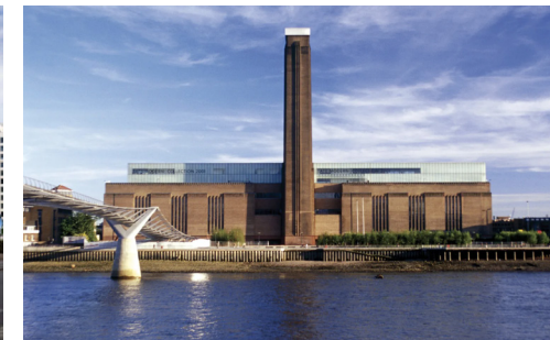
Imagen 31. Antigua central de energía de Bankside, Londres, Inglaterra. Fuente: Infobae (2022).
