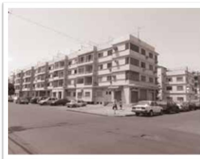
Figura # 17. Centro de Vivienda del IESS
