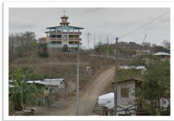
Figura #52. Vista de Monte Sinaí
