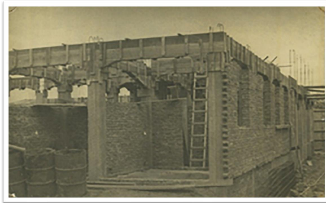
Figura #19. Construcción de las Paredes
