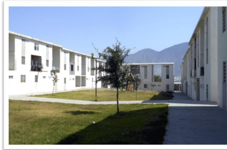
Figura #121. Vista del Proyecto
