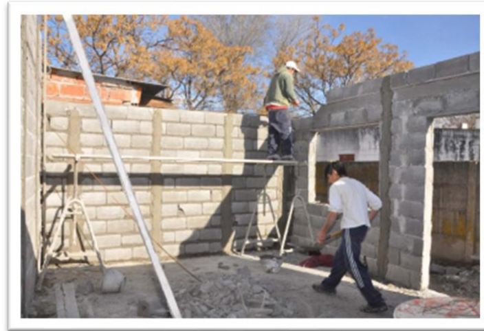
Figura # 25 Cimentación de las Paredes
