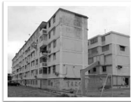
Figura # 23. Bloques Multifamiliares de la Ciudadela La Atarazana
