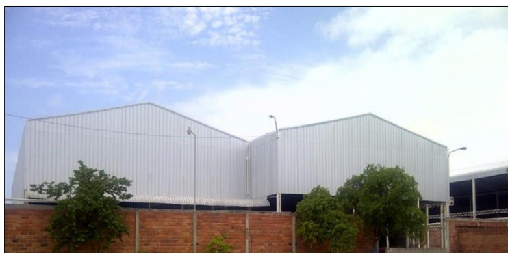
Figura #2: Fachada de las instalaciones de bodegas
