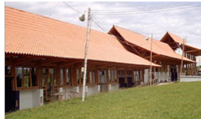
Imagen N°62: Vista lateral facultad de arquitectura. Fuente: (Morán, 2013).
