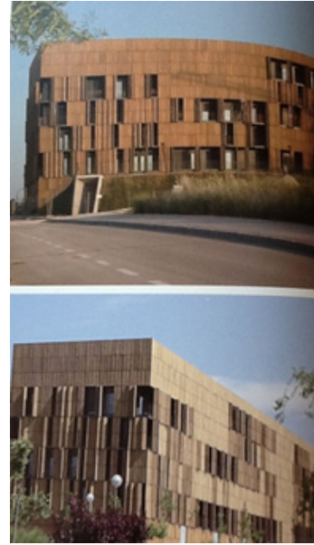
Imagen N°37: Fachada de casa pasiva en Bessancourt. Fuente: (Hervé Abbadie, 2012).
