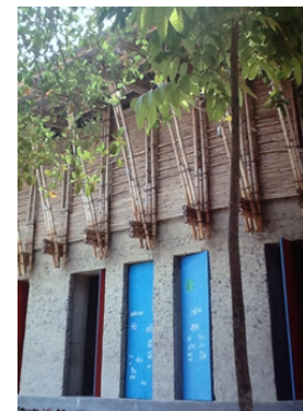
Imagen N° 44: Edificación en Bangladesh. Fuente: (Sánchez, 2012).
