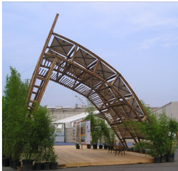
Imagen N° 39: Pabellón tecnológico de Bambú. Fuente: (Sánchez, 2012).
