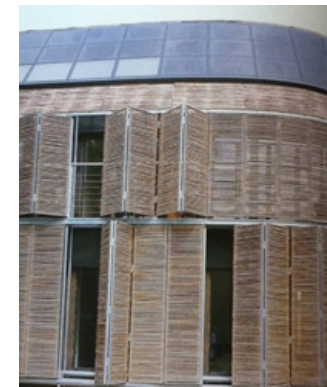
Imagen N° 56: Fachada granja. Fuente: (Sánchez, 2012).
