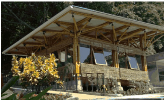
Imagen N° 72: Fachada biblioteca Eco-materiales. Fuente: Elaboración propia noviembre 16, 2013.
