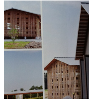
Imagen N° 55: Fachada granja. Fuente: (Sánchez, 2012).
