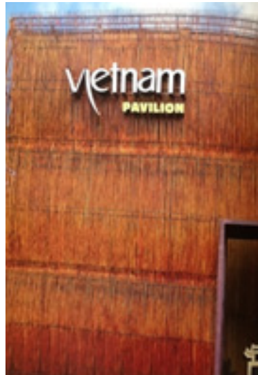
Imagen N°17: Exterior del pabellón de Vietnam. Fuente: (Sánchez, 2012).
