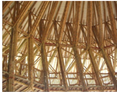
Imagen N° 67: Tumbado de paso peatonal. Fuente: (Morán, 2013).
