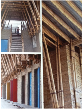
Imagen N° 45: Edificación en Bangladesh. Fuente: (Sánchez, 2012).
