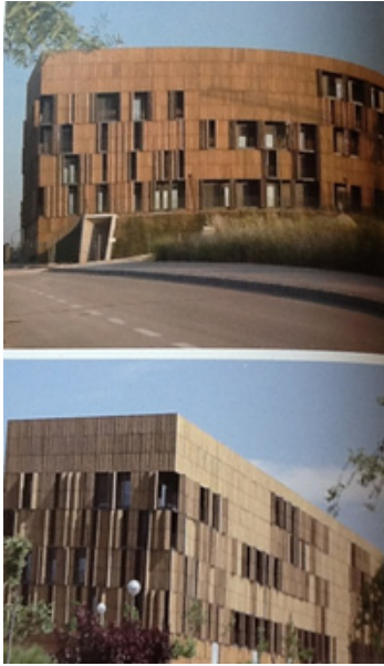
Imagen N°35: Fachada de casa pasiva en Bessancourt. Fuente: (Hervé Abbadie, 2012).
