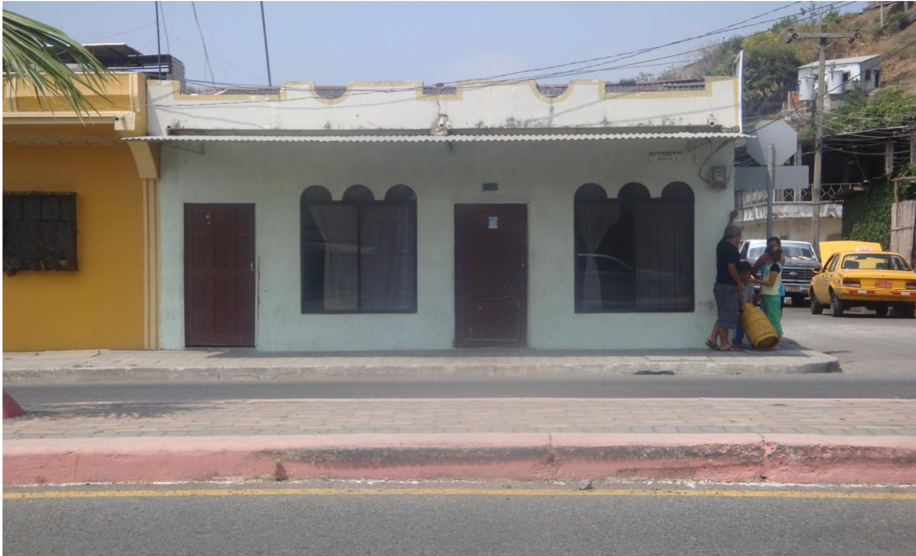
Vivienda Popular de Hormigón sencilla de una sola planta, Cantón Durán, Fotografía: Ma. Belén Falquez, 2009
