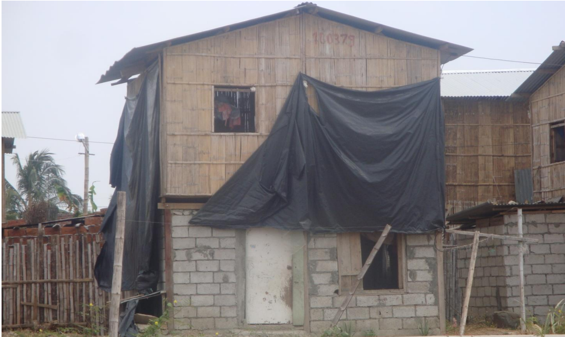
Vivienda tipo tradicional, cantón Durán. Se puede observar el crecimiento con materiales como el hormigón. Fotografía: Ma. Belén Falquez Fernández, 2009
