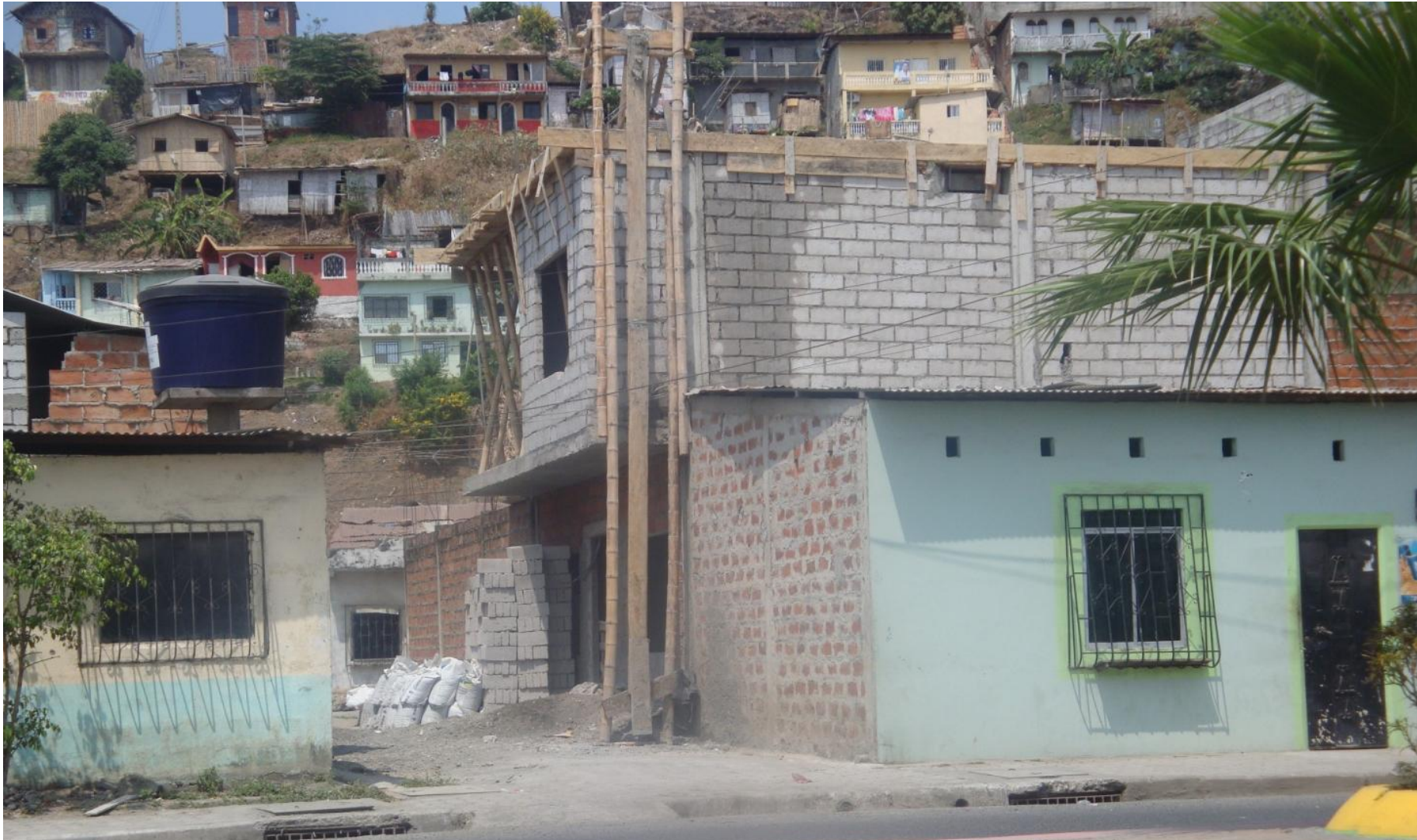
Vivienda Popular de Hormigón, Cantón Durán, se puede notar el enlucido de la fachada principal y el bloque visto en las laterales. Inclusive la forma de crecimiento de la vivienda posterior. Fotografía: Ma. Belén Falquez, 2009
