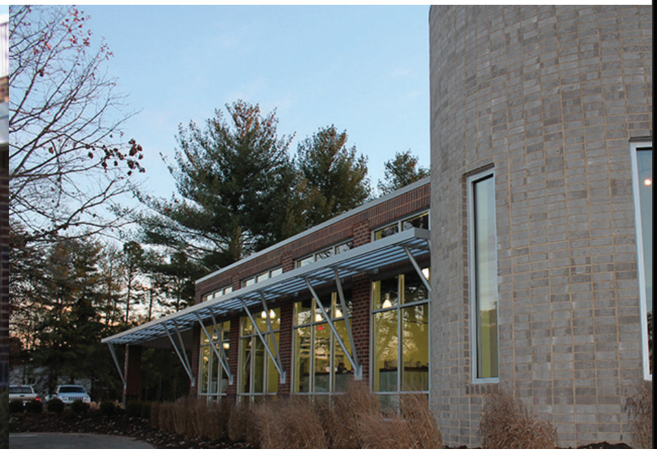
Imagen N 55 Utilización de piedra y ladrillos en el revestimiento exterior de la clínica Fuente:
