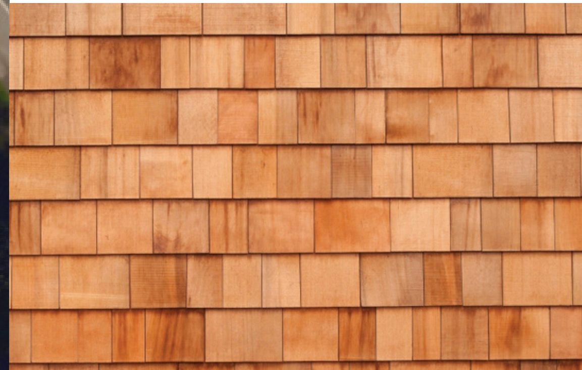
Imagen N 45 Revestimiento exterior, duelas de cedro Fuente: (iStock , 2016)
