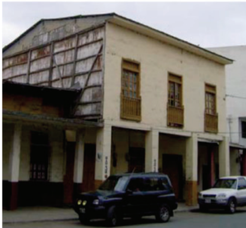
Gráfico No. 4: Casa Urbana de madera y caña, enquinchada. Inicios del siglo SXX
