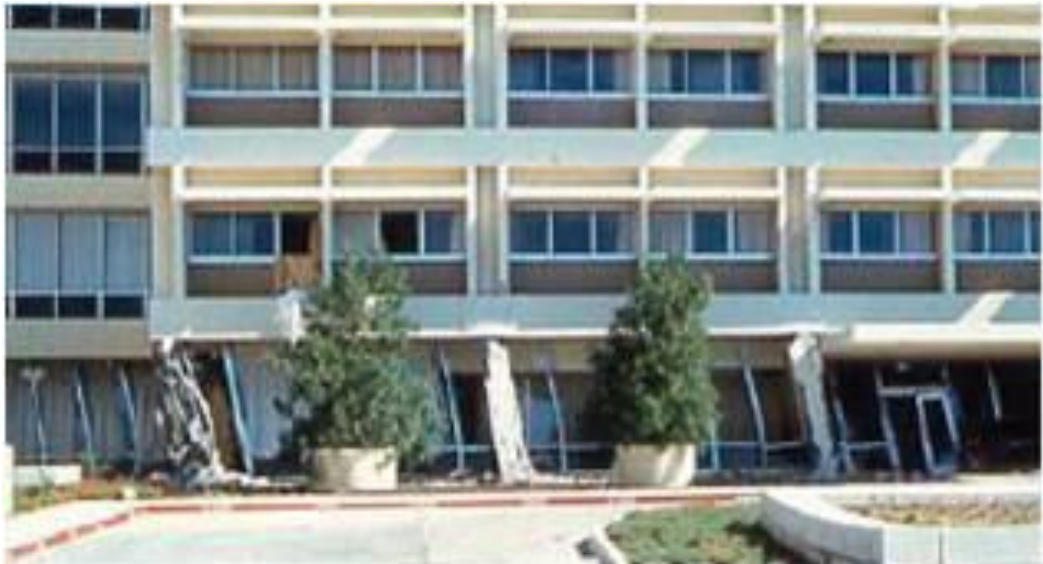
Gráfico # 4: Daño del Hospital Olive View
