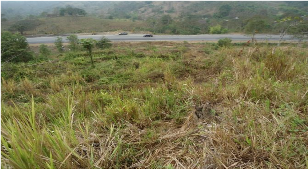
Foto 6.- Cuerpo del deslizamiento visto desde la corona.
