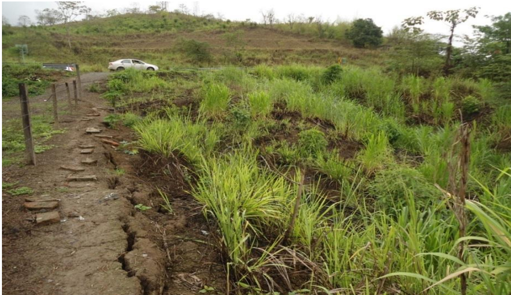
Foto 11.- Vista general del deslizamiento visto desde la "pata"
