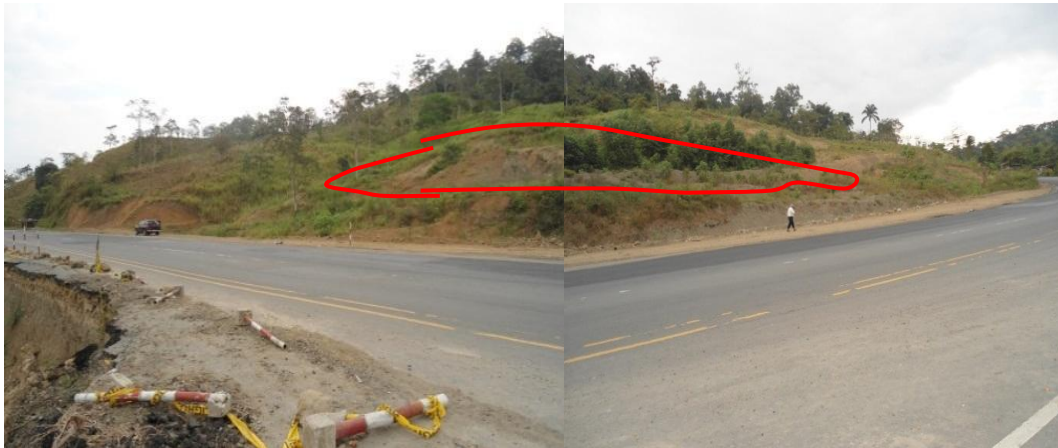
Foto 4.- Área de deslizamiento no removido.
