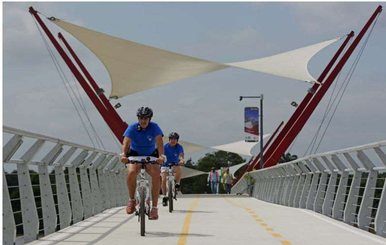
Ilustración 6: Puente Isla Santay
