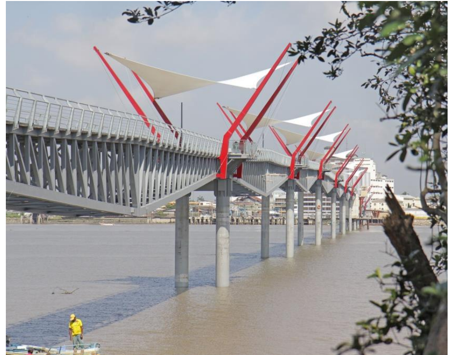
Ilustración 7: Puente Isla Santay
