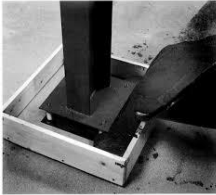
Imagen 9 Recubrimiento de hormigón para la placa base.
