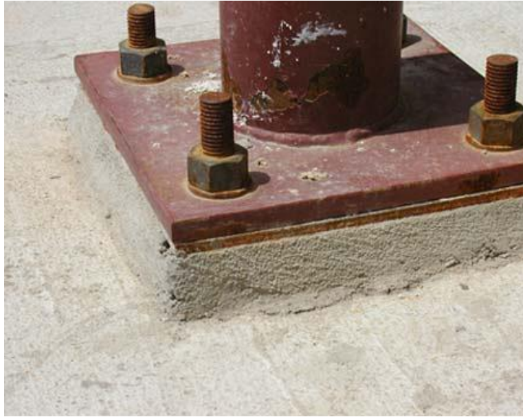
Imagen 3 Uso apropiado de una placa base con pernos simétricos en sus ejes.
