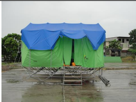
Ilustración 78: Estructura tubular. Fuente: Secretaria de Gestión de Riesgo.
