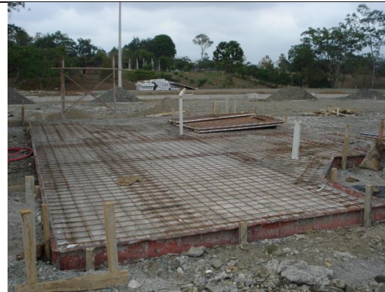
Ilustración 38: Losa de cimentación. Fuente: Ing. Adolfo Chiriboga
