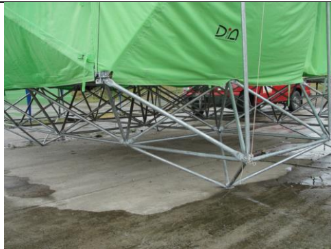
Ilustración 80: Base de la Estructura. Fuente: Secretaria de Gestión de Riesgo.
