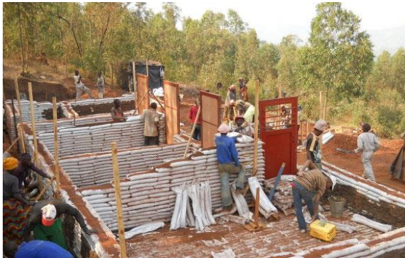
Ilustración 60: Sistema Earthbag. Fuente: Natural Living, http://www.naturallivinghq.com
