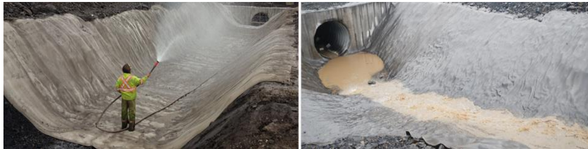
Ilustración 92: Construcciones con la tela de hormigón. Fuente: Concrete Canvas, http://www.concretcanvas.com/
