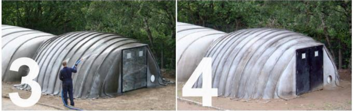
Ilustración 97: Fraguado de la Estructura. Fuente: Concrete Canvas, http://www.concretecanvas.com
