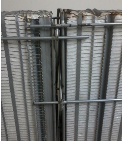
Ilustración 33: Detalle A MURROTEC. Fuente: Yomaira Velasco A.
