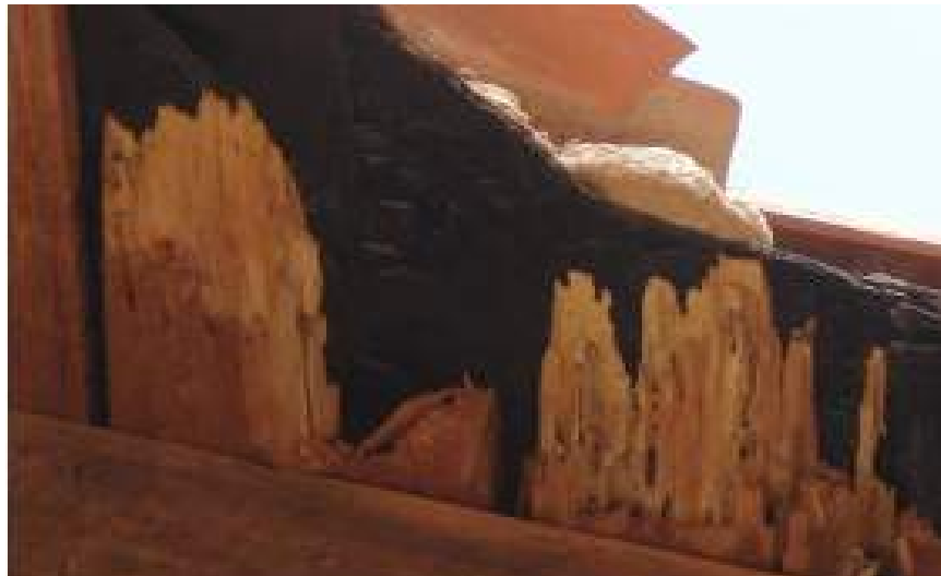
Gráfico 24 Ataque de polillas a la madera Fuente: ABC de conservación de viviendas tradicionales, universidad Simón Bolívar Venezuela, 2010
