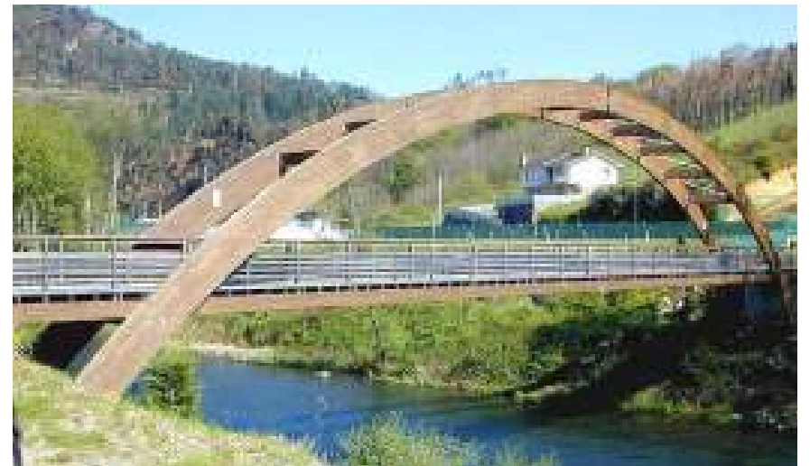
Gráfico 51 Puente Pontenova de 40m de longitud (España) construido con madera laminada Fuente: Tecnología de la madera aplicadas al diseño de estructuras.
