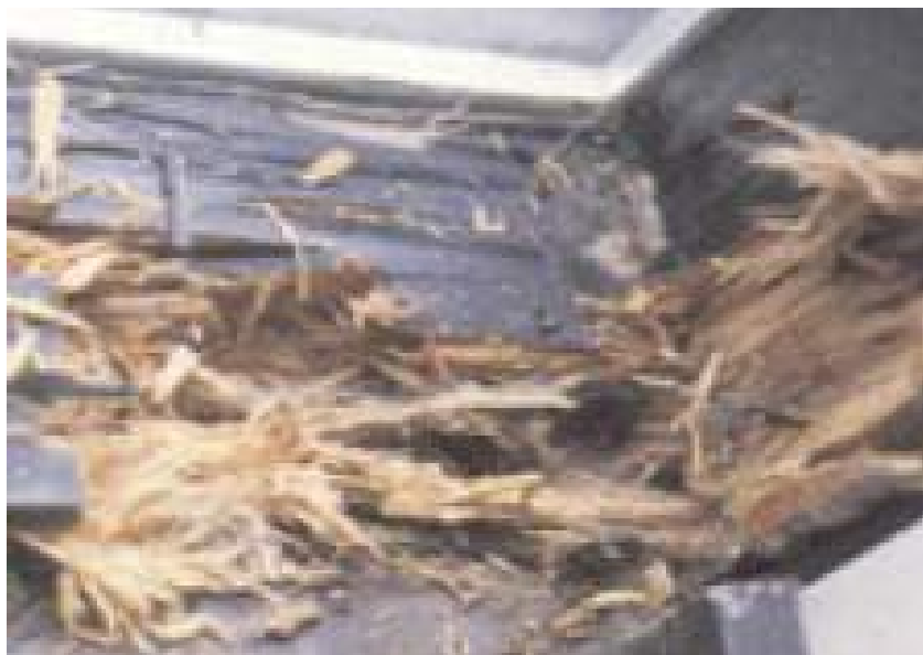
Gráfico 28 Pudrición blanca de la madera Fuente: Arq. Guillermo Gonzalez, Universidad del Bio Bio, 2012
