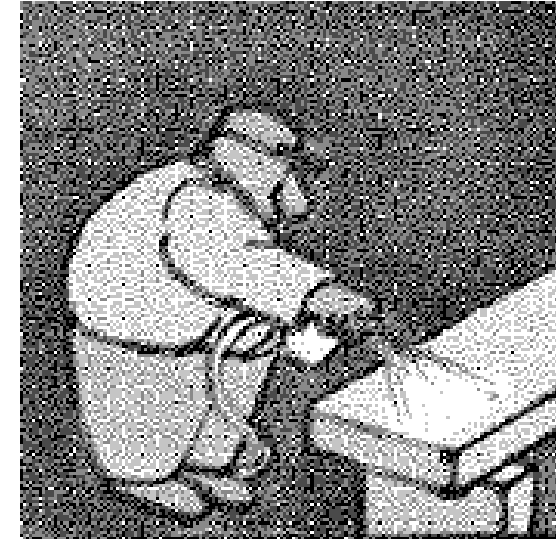
Gráfico 31 El pulverizado como método de preservación de la madera
