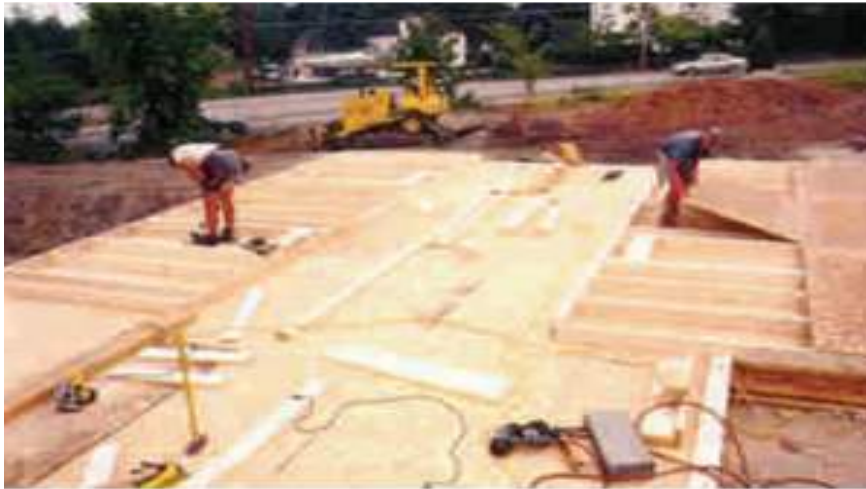
Gráfico 41 Plataforma sobre la que se colocan los tabiques. Fuente: Manual construcción de viviendas en madera.
