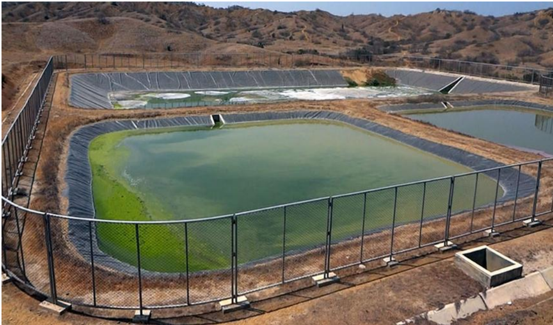
Ilustración 6 Lagunas de Almacenamiento del Municipio de Contralmirante Villar en Acapulco – México
