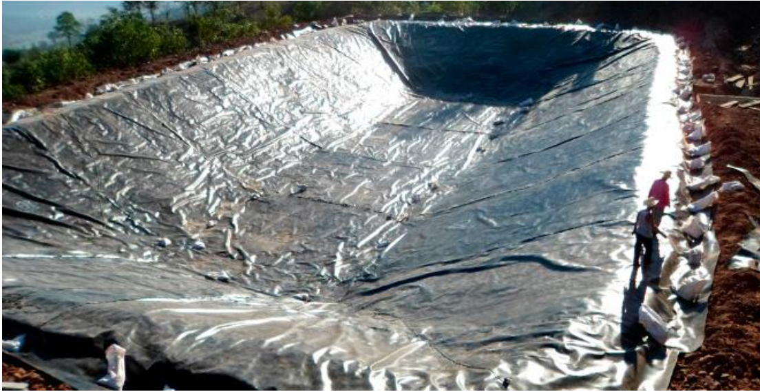
Ilustración 5 Empleo de Geo sistemas en Sistema de Captación de Agua Pluvial
